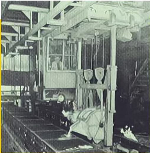
3 ЗАЛИВКА, ОСУЩЕСТВЛЯЕМАЯ ИЗ КАБИНЫ УПРАВЛЕНИЯ
